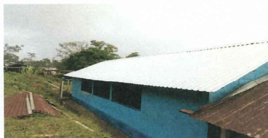
Foto 2: CUBIERTA DE LAMINAS TROQUELADA TERMINADO
