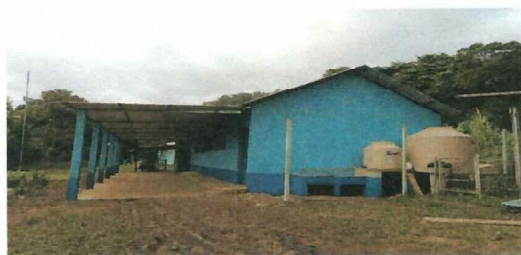
Foto 2: TRABAJOS FINALIZADOS EN LA PARTE DE ATRÁS Y COSTADOS DE LA ESCUELA
