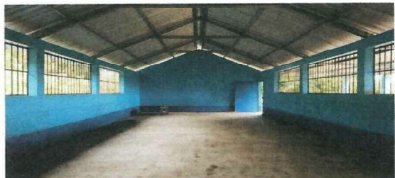
Foto1: . PINTURA FINALIZA INTERIOR Y EXTERIOR
