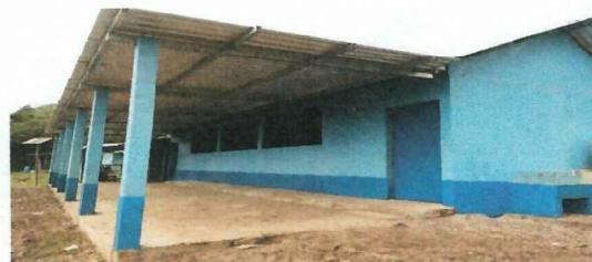
Foto 4: VISTA DE FRENTE Y CORREDOR DE LA ESCUELA
